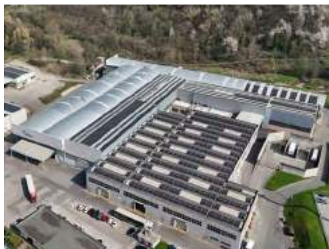
Capannone Oggiono - Impianto fotovoltaico 1MWh
