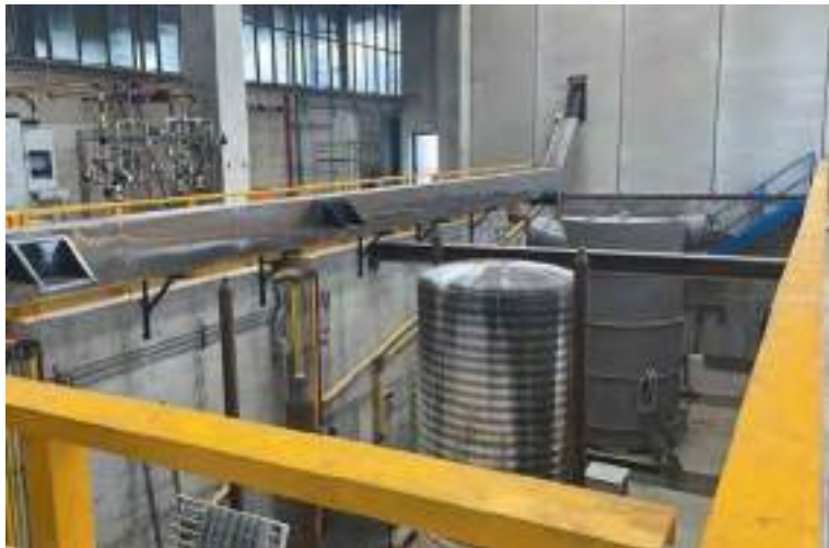
Plant di Oggiono - Nuova buca per forni oggetto di revamping
